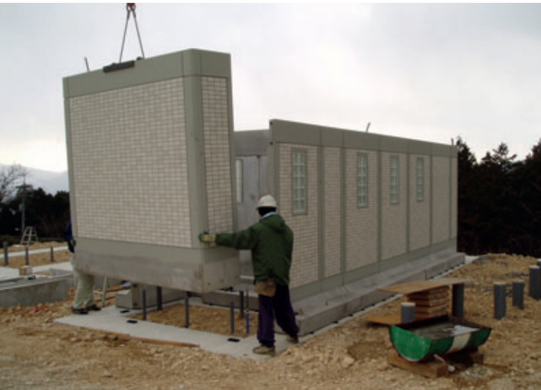
Şek. 2 ve 3: Prekast parçaların şantiyede birleştirilmesi.
